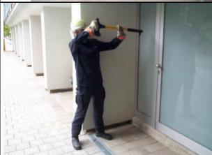
Drahtglas wird von oben nach unten mit der Stoßklinge eingestoßen. Die Werkzeuglänge fungiert hierbei als Sicherheitsabstand, um außerhalb des Gefahrenbereich des herunterkippenden Glases zu arbeiten.
