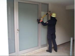
Sicheres Einschlagen einer Glasscheibe: In dieser Position bildet das Axtblatt den tiefsten Punkt, die Hände befinden sich oberhalb.
